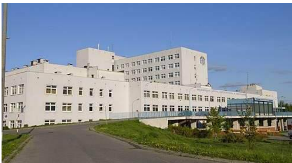
Ryc.3. Widok przebudowywanego budynku Szpitala
