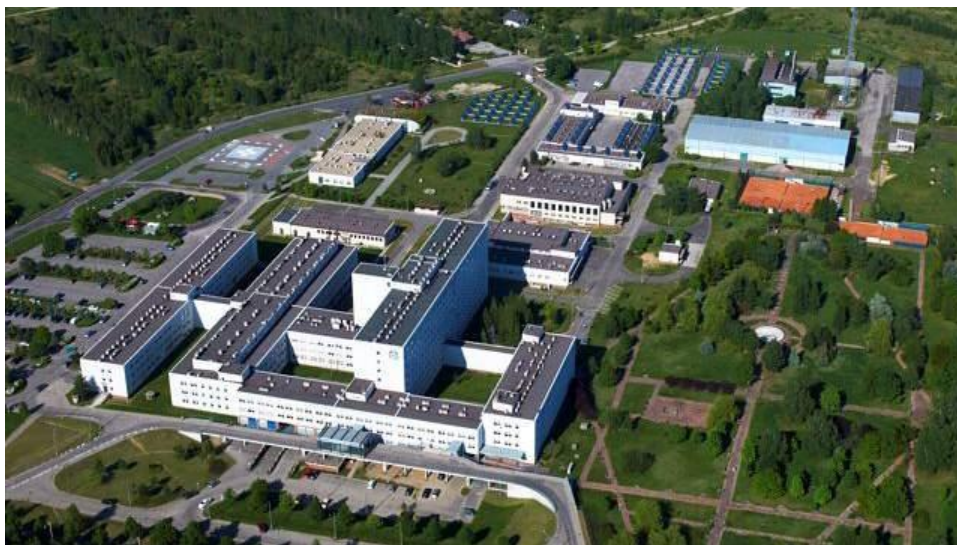
Ryc.2. Widok przebudowywanego budynku Szpitala
