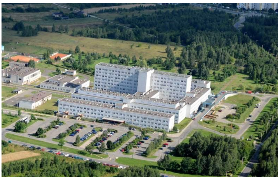
Ryc.1. Widok przebudowywanego budynku Szpitala
