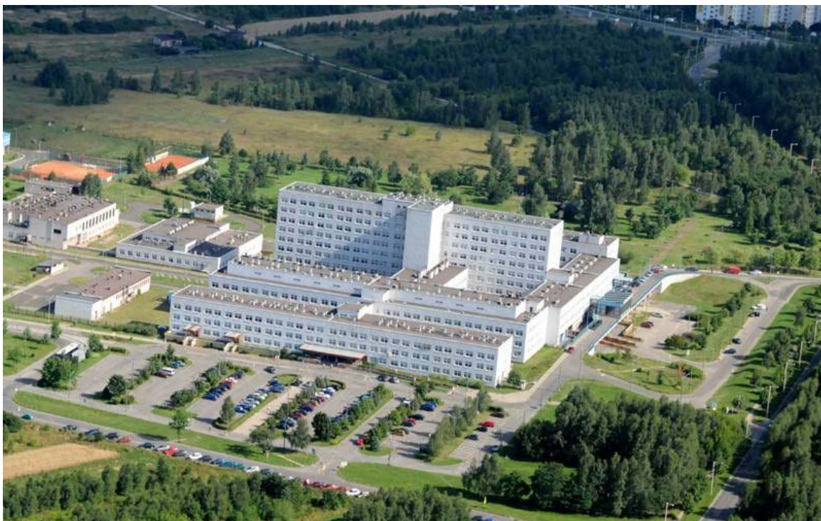
Ryc.2. Widok przebudowywanego budynku Szpitala
