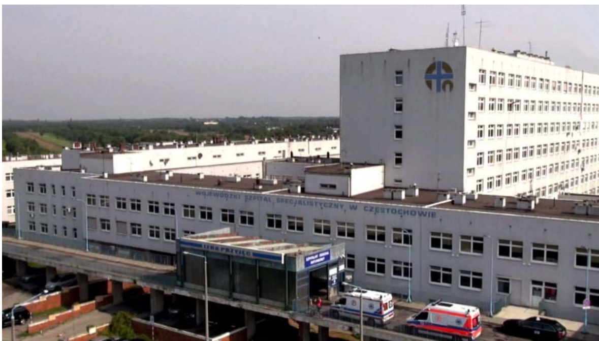
Ryc.5. Widok przebudowywanego budynku Szpitala
