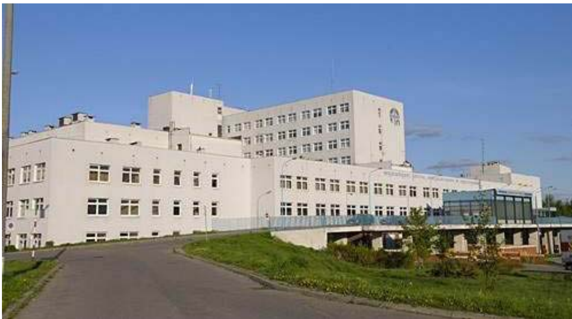
Ryc.4. Widok przebudowywanego budynku Szpitala
