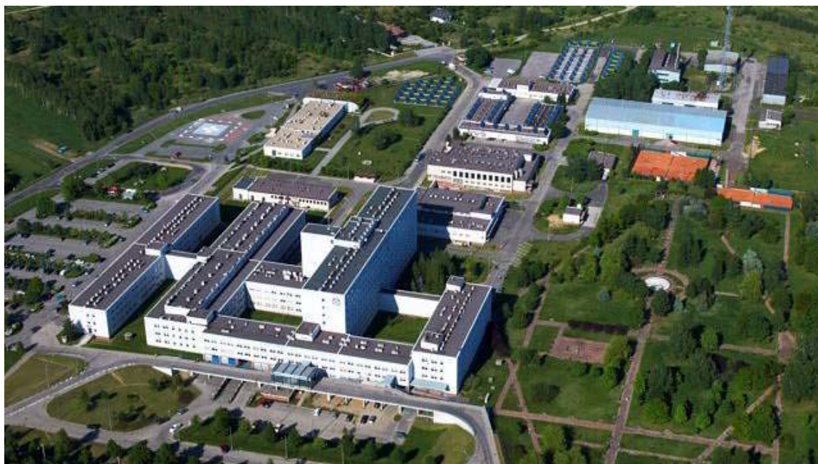
Ryc.3. Widok przebudowywanego budynku Szpitala
