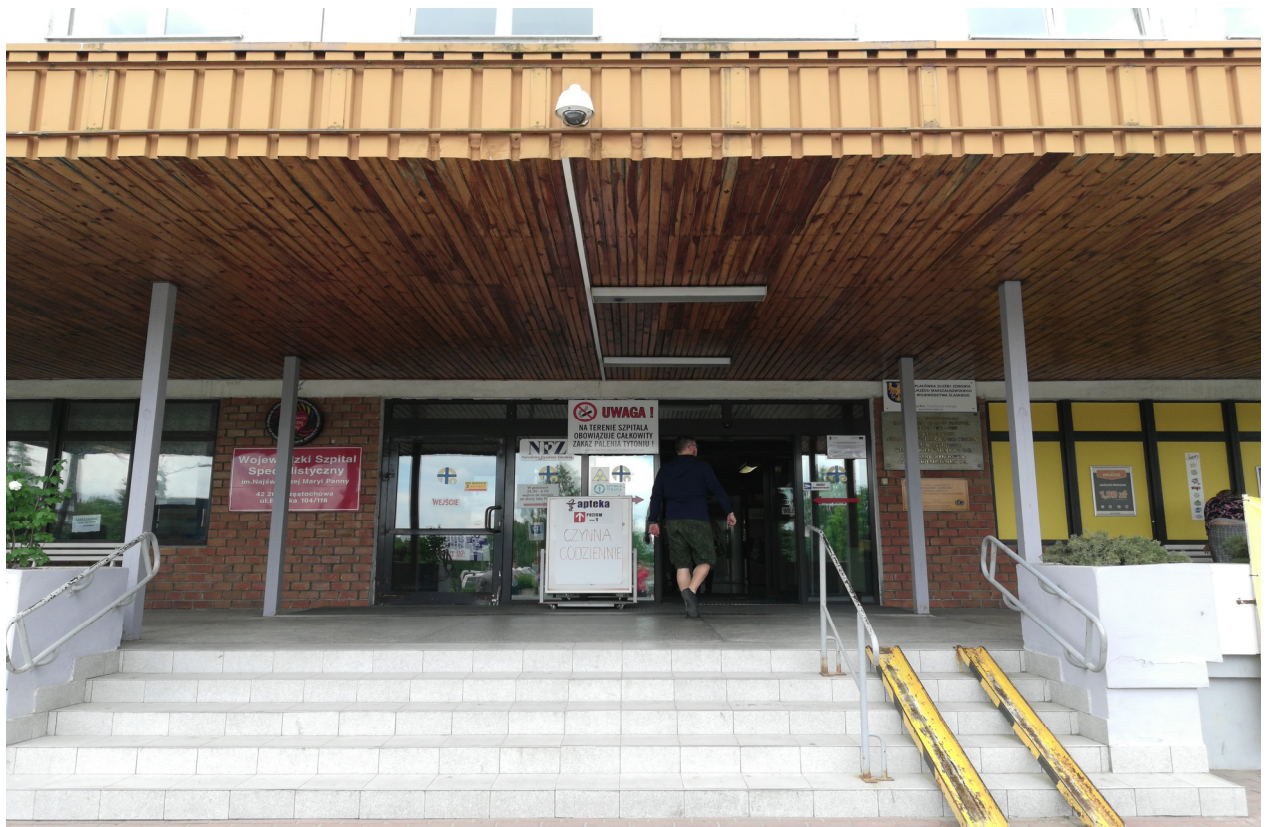
Wejście główne do budynku
