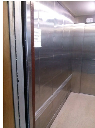
dźwig BUDYNEK E
