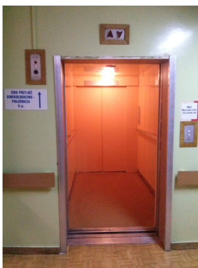
dźwig BUDYNEK C
